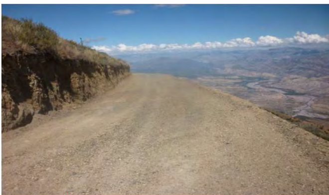
CONSTRUCCIÓN Y MEJORAMIENTO DE LA CARRETERA LA MERCED – FORTALEZA TORONGANA,
