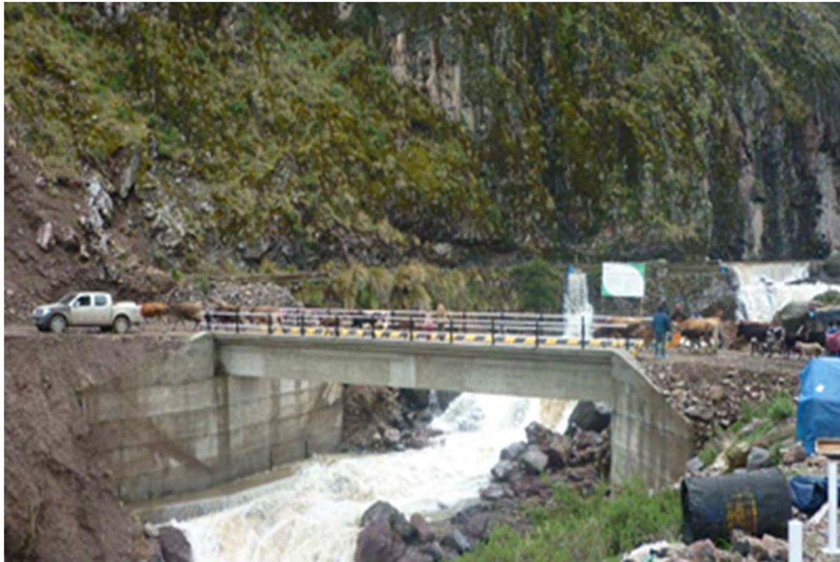
CONSTRUCCIÓN DE PUENTE CARROZABLE TAMBO ESMERALDA
