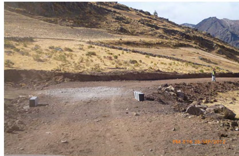
CONSTRUCCIÓN DE LA CARRETERA HUAYACCA - ANTACANCHA - COCHAMARCA
