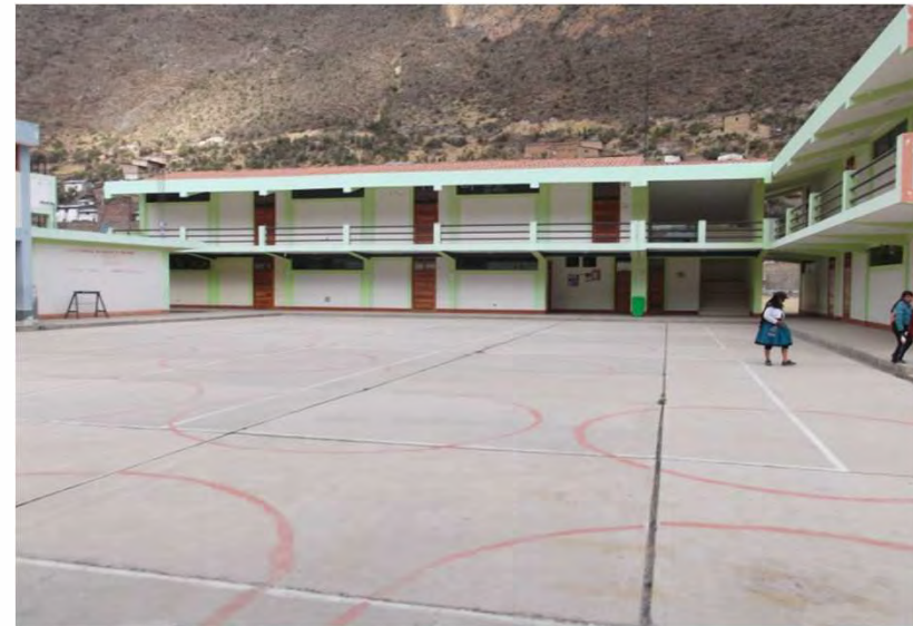
AMPLIACION DE INFRAESTRUCTURA DE LA I.E. DE MUJERES NUESTRA SEÑORA DEL CARMEN- LIRCAY
