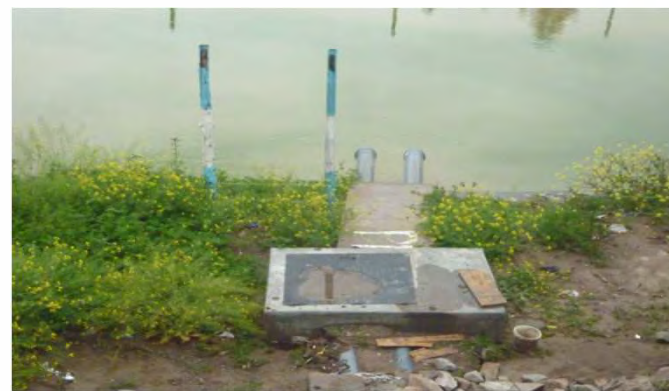
CONSTRUCCIÓN DEL SISTEMA DE RIEGO TECNIFICADO WACCRACCASA– EL CHORRO -PAMPAPUQUIO – WAYRAPATA - PACCHA
