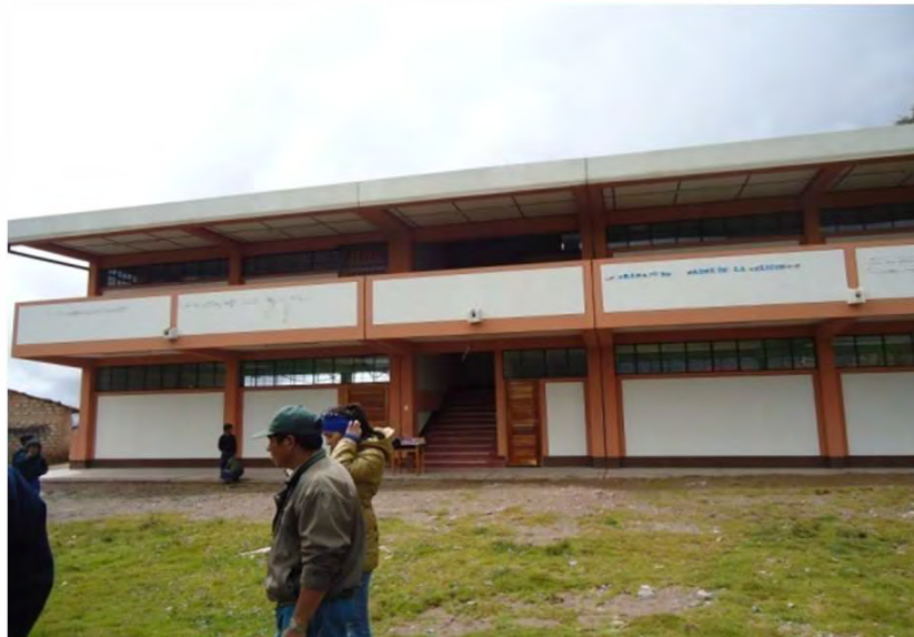
CONSTRUCCION Y EQUIPAMIENTO DE LA I.E. ENRO 36286 CUTICSA-PROV. ANGARAES
