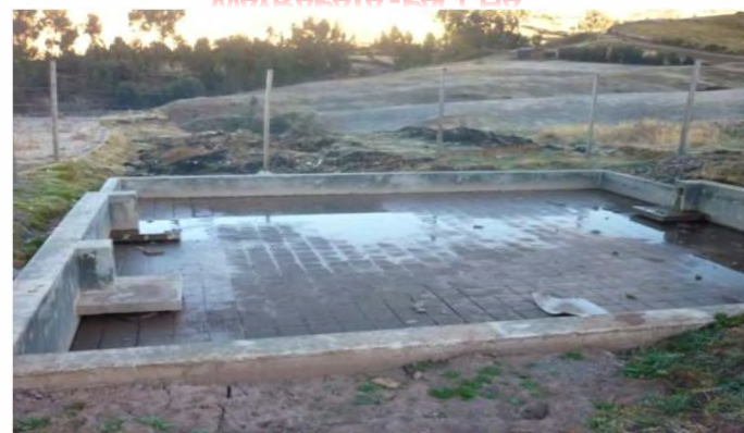
AMP, MEJ. DEL SISTEMA DE AGUA POTABLE Y CONST. DEL SISTEMA DE ALCANTARILLADO EN LA LOCALIDAD DE YAURECCÁN,
