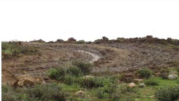
CONST. DE LA CARRETERA HUACHAJE - SAN ISIDRO DE POTACA- SAN JUAN DE VISTA ALEGRE- EMPALME A VÍA DE SAN JUAN DE CORERAC DE SANTIAGO DE CHOCORVOS.
