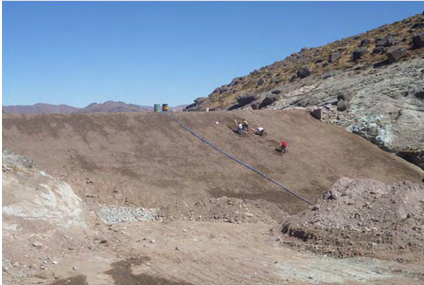
CONSTRUCCION DEL VASO DE REPRESAMIENTO DE HUARAJO
