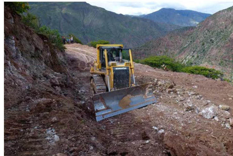
CONSTRUCCIÓN DE TROCHA CARROZABLE RURUNMARCA LLAHUECC – RÍO MANTARO
