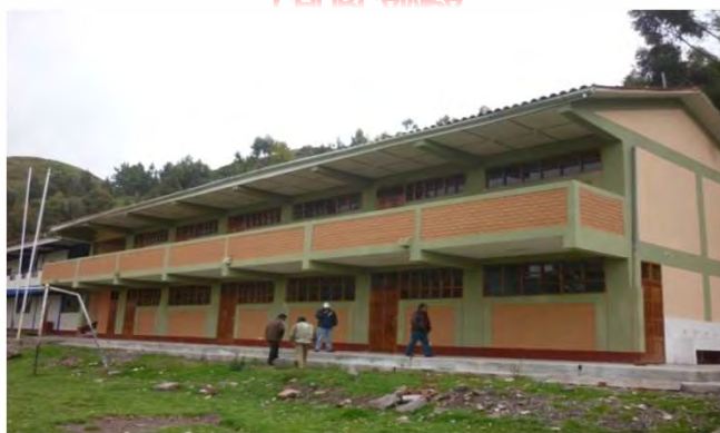
CONSTRUCCIÓN DE INFRAESTRUCTURA EDUCATIVA EN LA INSTITUCIÓN EDUCATIVA N° 30989 "JESUS DE NAZARETH"
