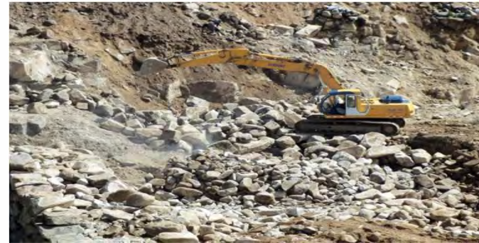
CONSTRUCCIÓN CANAL DE RIEGO ILLAHUASI- HUIRPACANCHA
