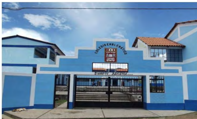
CONSTRUCCION, AMPLIACION, REHABILITACION Y MEJORAMIENTO DE LA I.E.S. "ANTONIO RAIMONDI" DE CHURCAMP
