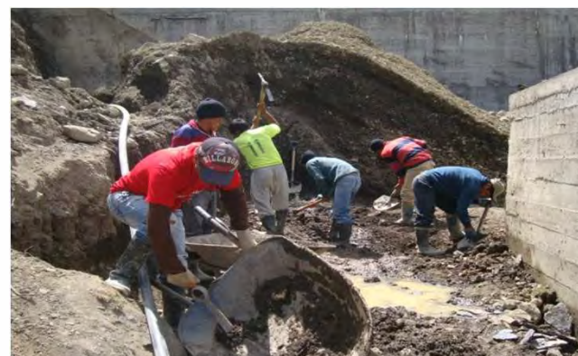
MEJORAMIENTO (REFORZAMIENTO) DIQUE DE PRESA ISLACCOCHA
