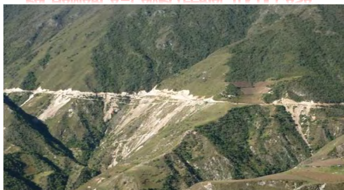
CONSTRUCCIÓN CARRETERA URPAY – PATAHUASI HUAYLLABAMBA - CHACHAS
