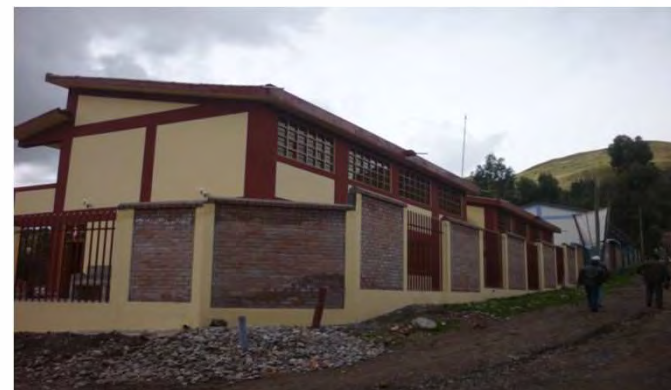
CONST. Y MEJ. DE LA INFRAESTRUCTURA DE LA I.E.S. "CÉSAR VALLEJO"
