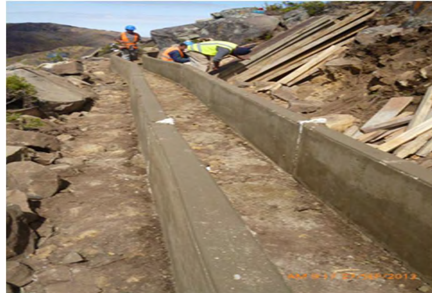
MEJORAMIENTO DE LA IRRIGACIÓN RUNTUPAMPA-PAMPACANCHA-CAJAMARCA
